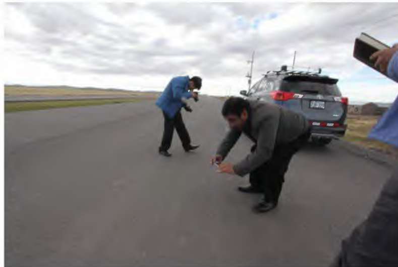
Verificando los empalmes de la carpeta asfáltica
