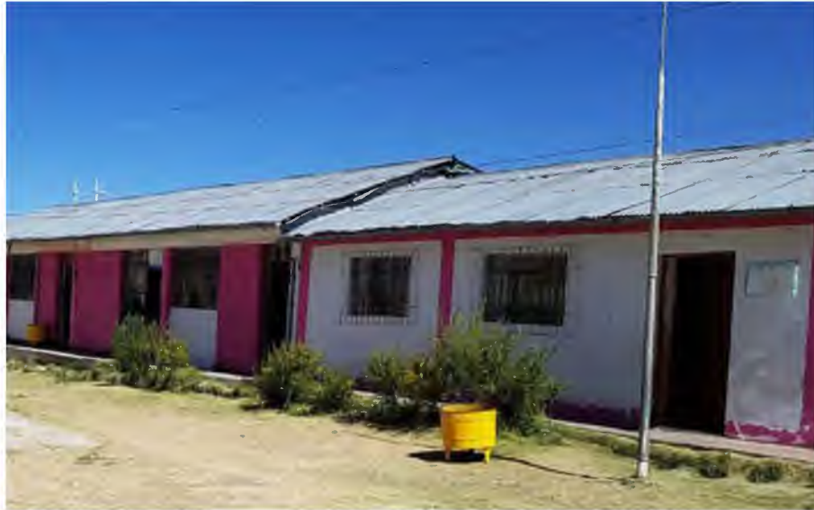
Infraestructura de la IEP N° 70018 San José de Puno.
