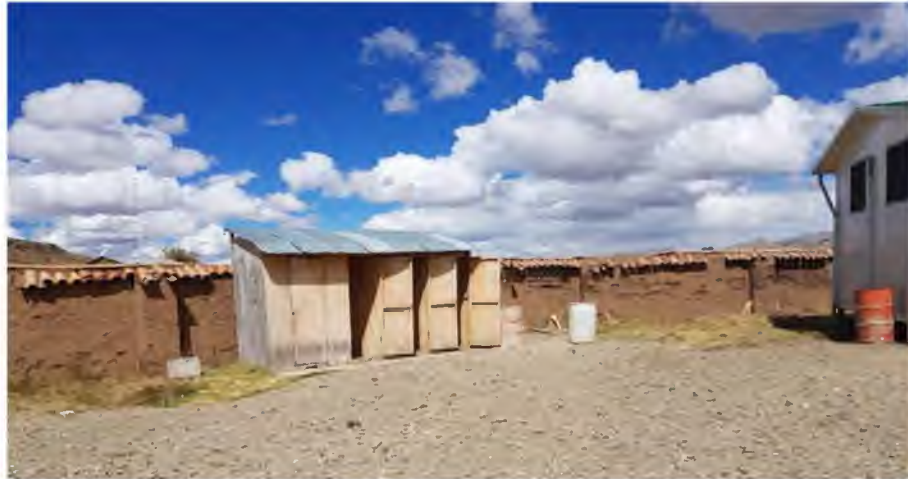
SERVICIOS HIGIÉNICOS PARA EL PERSONAL OBRERO DE LA OBRA: CONSTRUCCIÓN DE LA I.E. MARIANO MELGAR DE AYAVIRI, QUE SE ENCUENTRA PARALIZADO.
