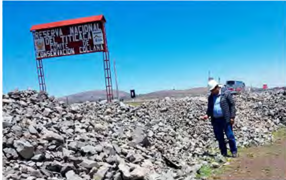
En nuestro rol de fiscalización en la Obra "Segunda Calzada de la Carretera Puno – Juliaca".
