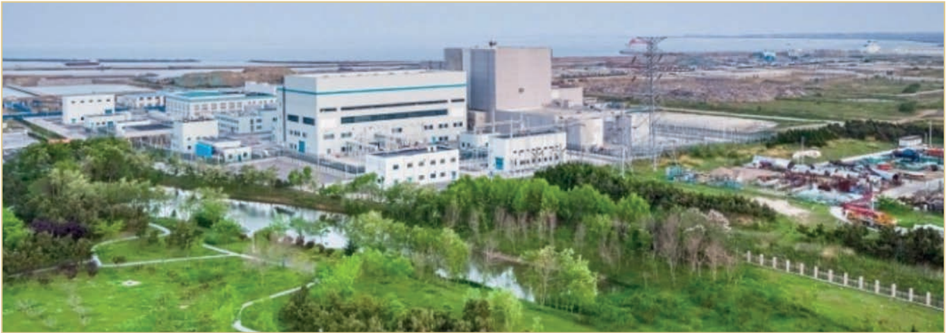
Figura 10. Emplazamiento del reactor HTR-10 en la central de Shidao Bay
