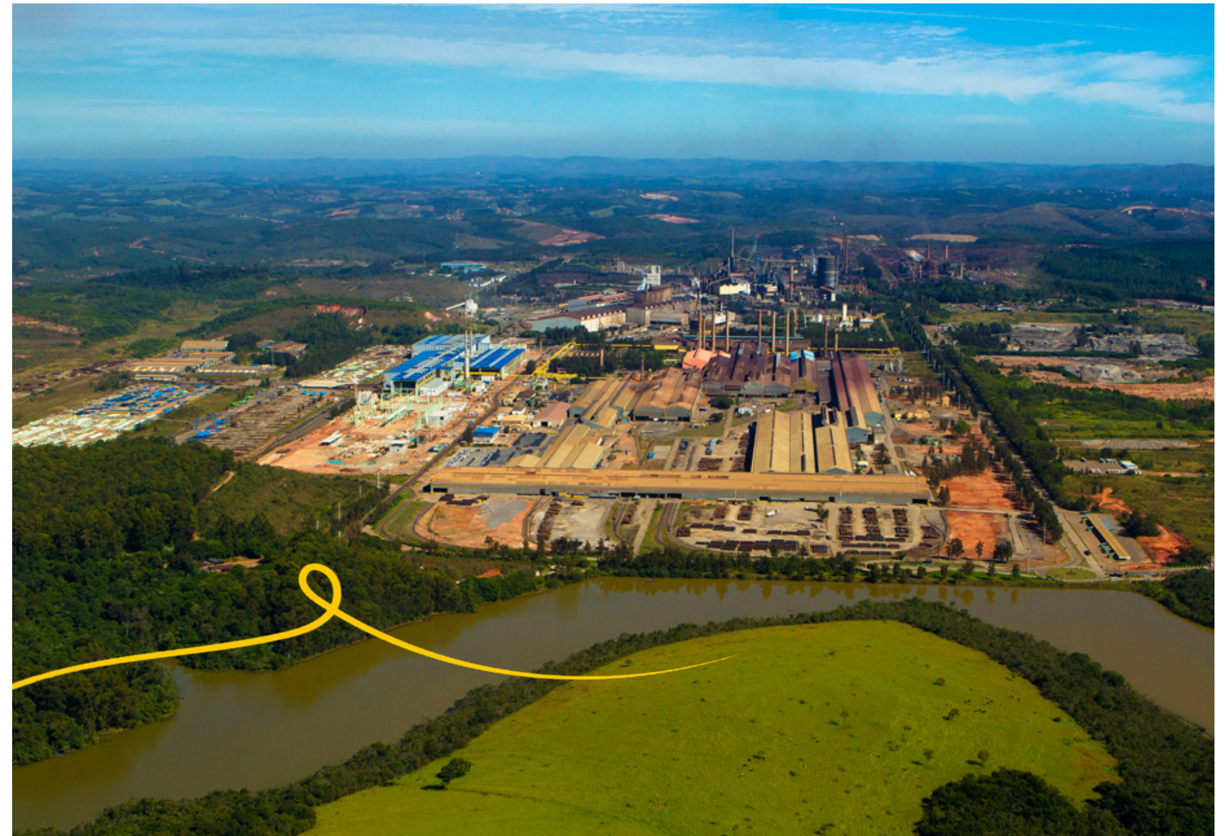
Gerdau Ouro Branco Mill (MG)
