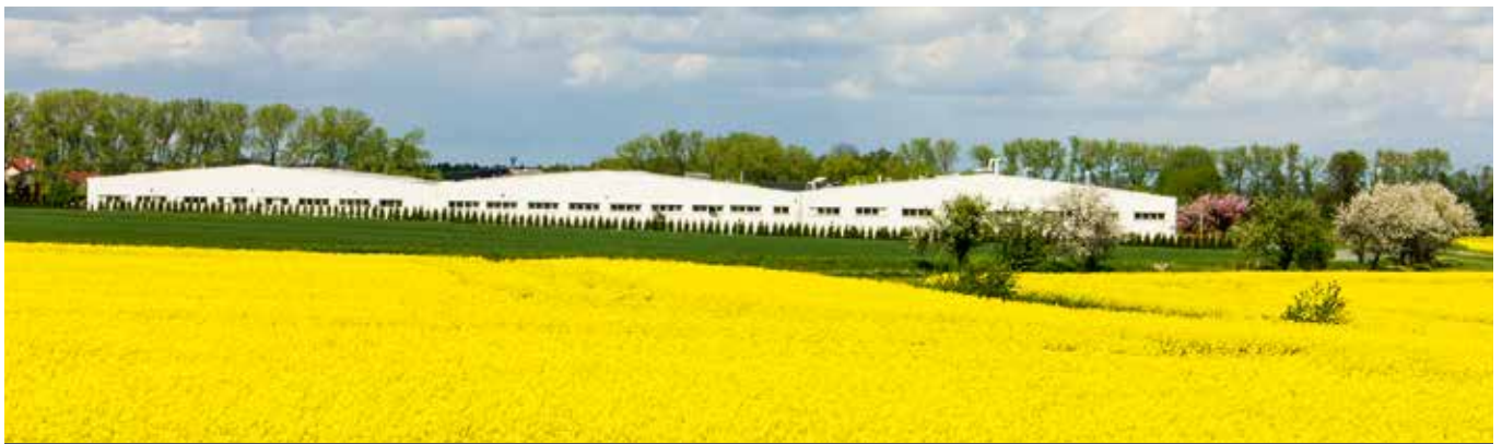
2018 - Der Blick von Gemeinde Dubany auf die neue vierte Produktionshalle für die immer größer werdende Kleiderschrank- und Spezialmöbelproduktion
