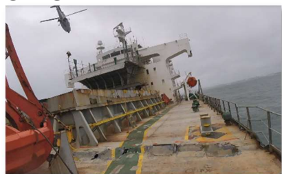
貨物船の船体亀裂部
