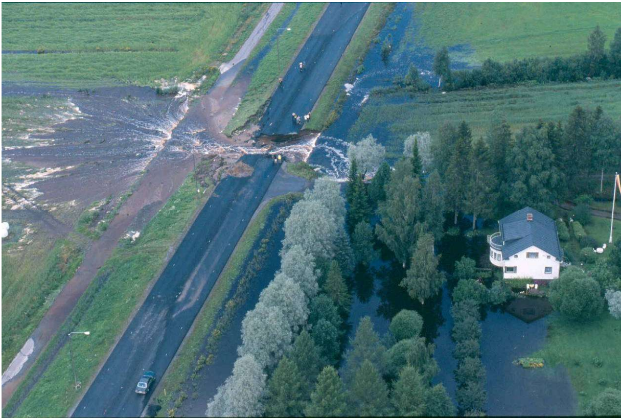
Bild 6. Under översvämningen år 2004 blev man tvungen att gräva av riksväg 8, eftersom Änäs stenbro dämde upp Kimo å, så att vattnet sökte en ny flödesrutt. Bilden är från Kimo ås avrinningsområde. (Unto Tapio)
