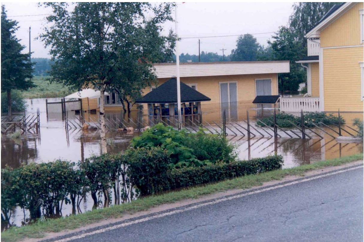
Bild 7. Under översvämningen i augusti 2004 uppkom skador på byggnader. Bilden är från Vörå ås avrinningsområde. (Eero Kyrönlahti)
