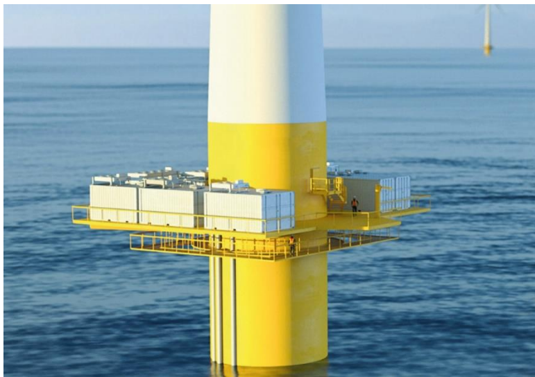
Kuva 3. Esimerkki elektrolyysilaitteistosta tuuliturbiiniin yhteydessä (AquaVentus, 2022).
