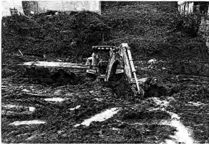
INICIO DE EXCAVACIÓN DE PCA-4 EN LA ZONA DE ESTUDIO
