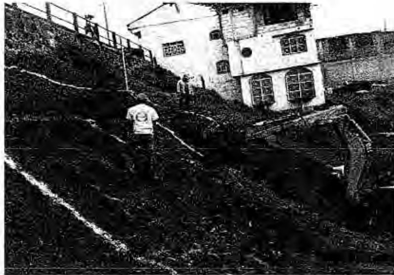
INICIO DE EXCAVACIÓN DE PCA-2 EN LA ZONA DE ESTUDIO.
