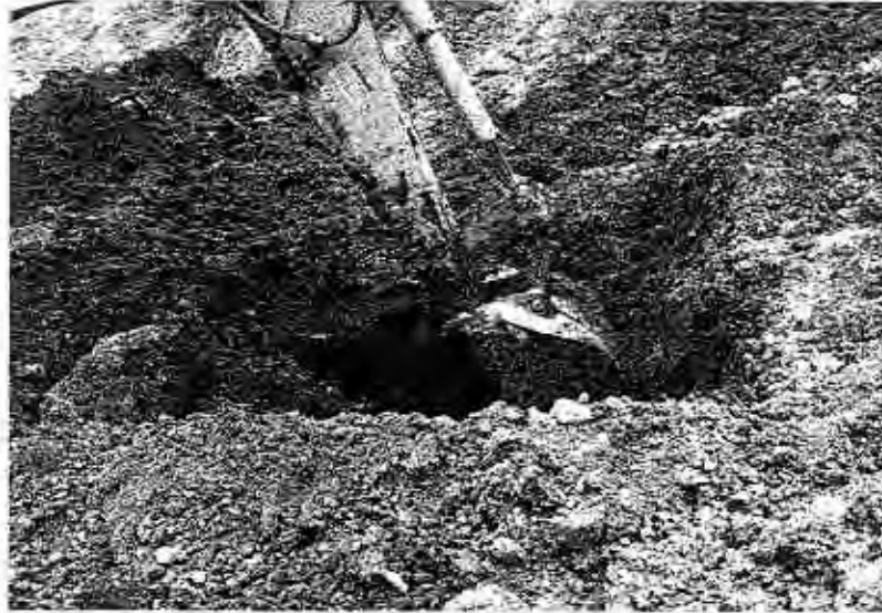
INICIO DE EXCAVACIÓN DE PCA-3 EN LA ZONA DE ESTUDIO
