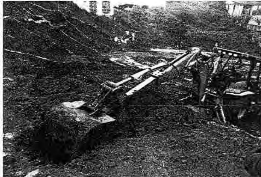
INICIO DE EXCAVACIÓN DE PCA-1 EN LA ZONA DE ESTUDIO
