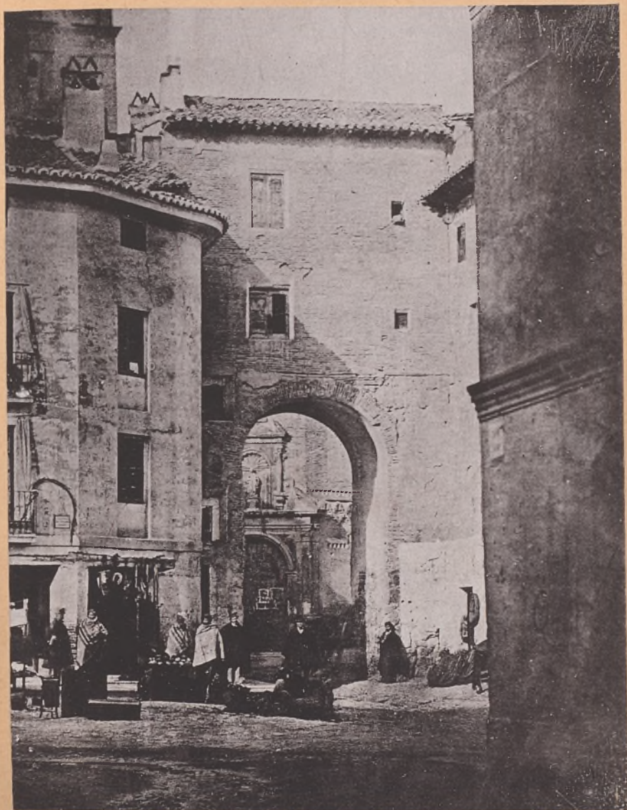
ARCO DE VALENCIA (cara anterior) hoy derruida.
