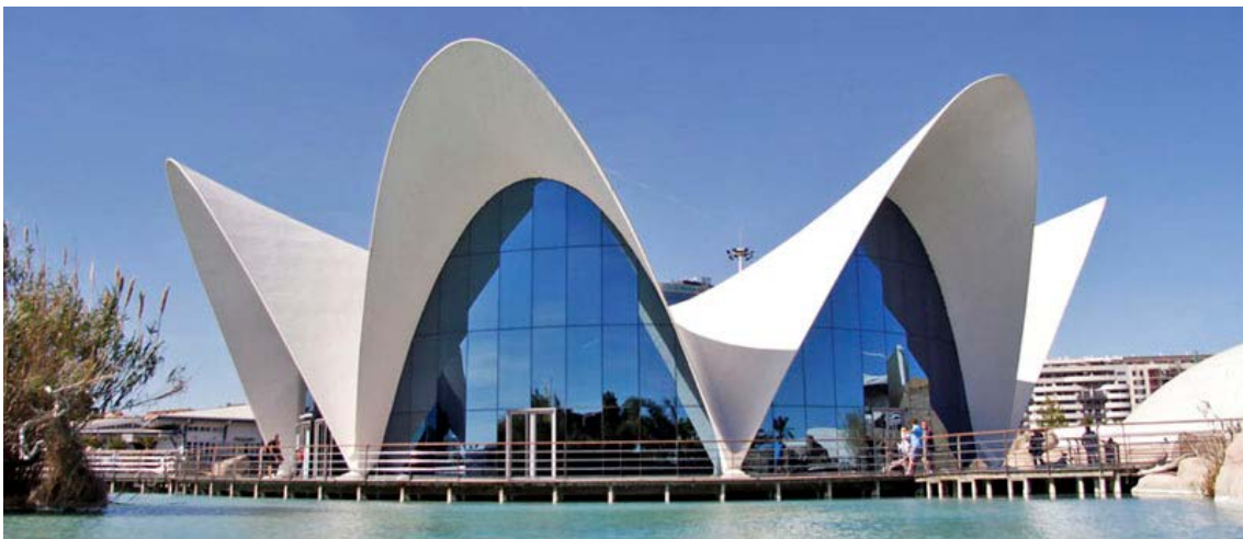
Figura 8. Edificio con fachada de forma de paraboloides hiperbólicos en Valencia.
