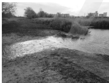
Рис. 2. Плотина (октябрь 2011 г.)
