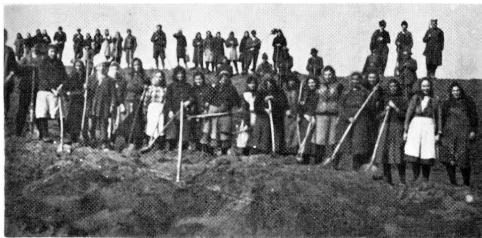
Сл. 167 — Оправка порушеног насипа у Сремској Рачи (јануара 1944)
