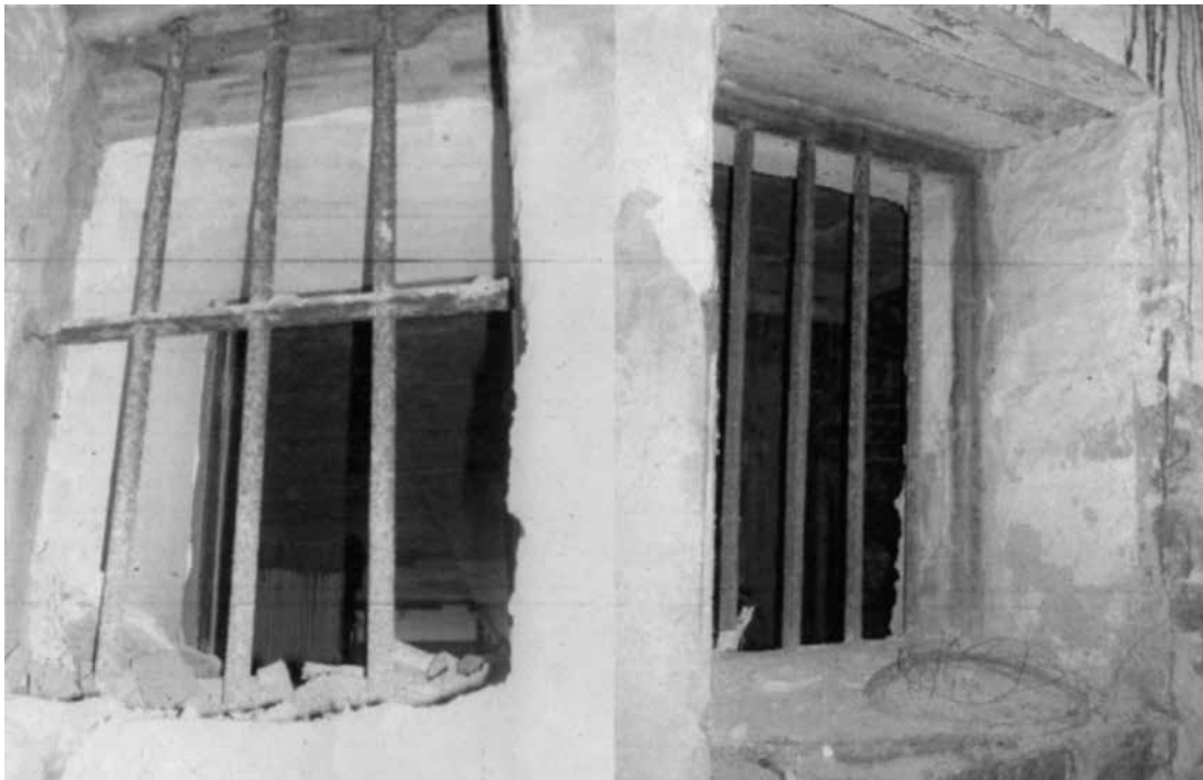
Zumaiaiko Udaletxeko kartzela- ren burdin sarea. / Rejas de la antigua cárcel de Zumaia, en los bajos del Ayuntamiento.
