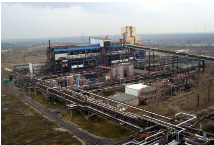
Ehemalige Rohgaserzeugungsanlage mit mehreren Gasgeneratoren in Schwarze Pumpe
