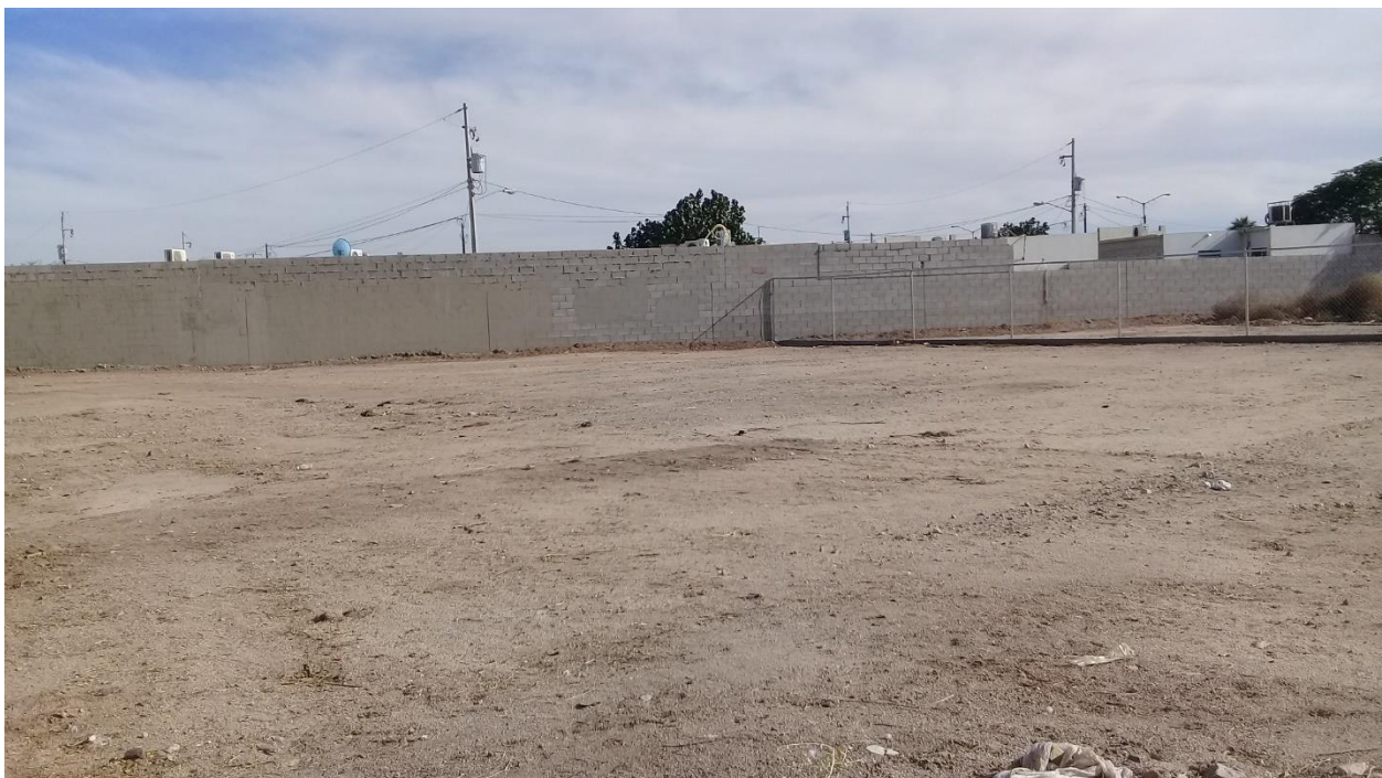
Foto 3 La barda de block que se ve al fondo separa al predio para el proyecto de la zona habitacional.
