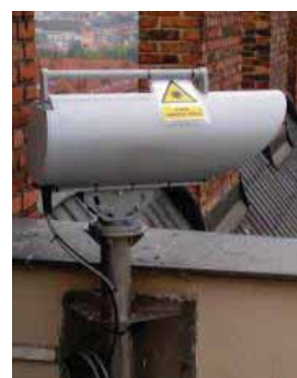
Instalace na MENDELU
