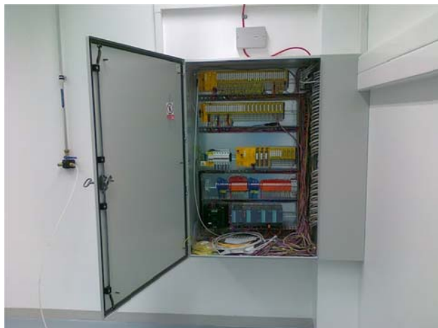
Obr. 2: Rozvodná skříň s PLC Pilz, switchem a UPS
