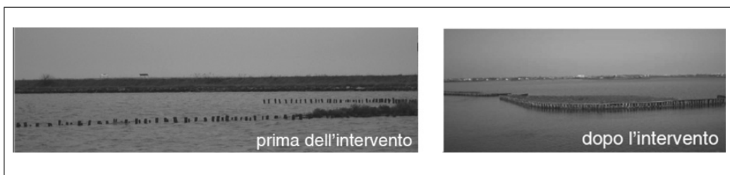
Riscavo del tratto terminale del canale sub-lagunare Fattibello e del canale Ungola (Azione C1) - LIFE09/NAT/IT/110. Fonte: Progetto LIFE09/NAT/IT/110
