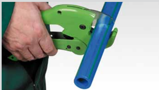
Corte de la tubería
