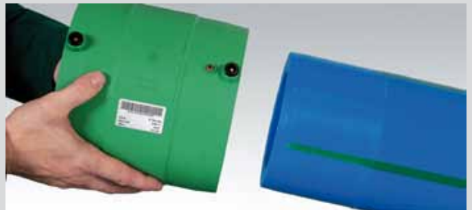
Introducir el manguito electrosoldable hasta la profundidad marcada
