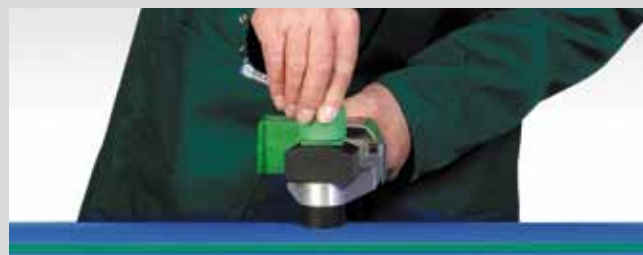
...calentando la tubería y el accesorio
