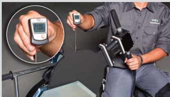
Medición de la temperatura en máquina de soldar a tope
