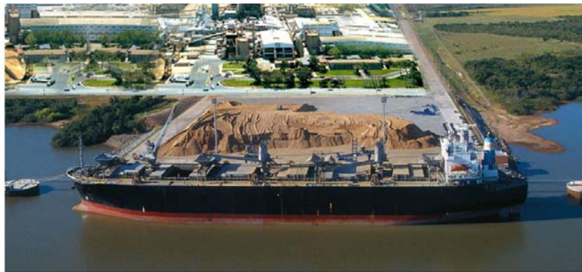
Celulosas de M'Bopicuá
