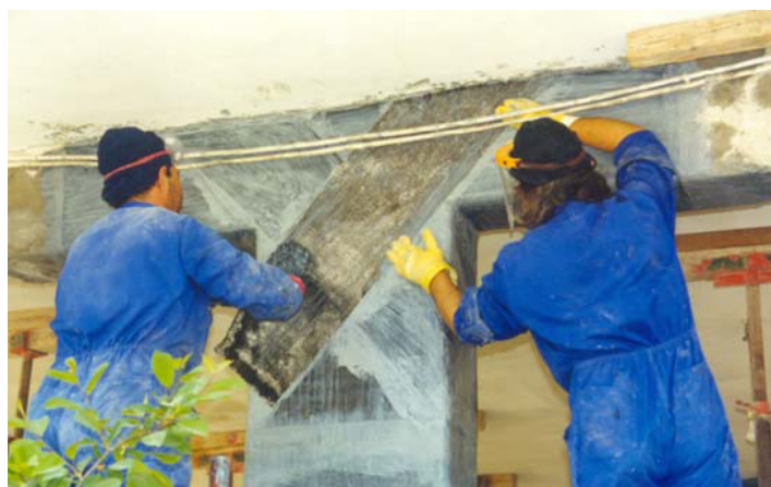
Εικόνα 3.4. Τυπικές εφαρμογές ΙΟΠ ως υλικά ενίσχυσης σε κατασκευές από οπλισμένο σκυρόδεμα: (α) καμπτική ενίσχυση πλάκας, (β) καμπτική ενίσχυση δοκού, (γ) και (δ) διατμητική ενίσχυση και περίσφιγξη υποστυλώματος, (ε) περιτύλιξη δεξαμενής, (στ) διατμητική ενίσχυση κόμβου δοκού - υποστυλώματος (fib, 2001).
