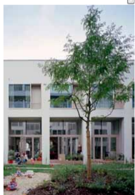
Für die Projekte in der Zelterstrasse übertragen die Architekten die Prinzipien des Reihenhausens in einen städtischen Kontext.
