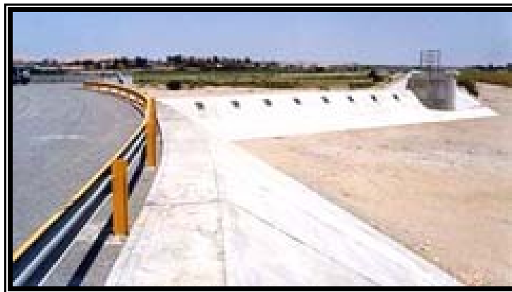
PROYECTO ESPECIAL "TAMBO CCARACOCHA" Dique Baraja (Dpto. Ica- Huancavelica)
