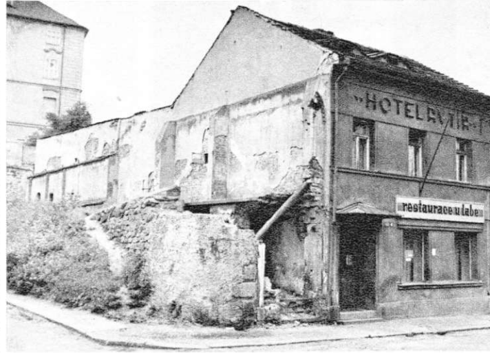
Verfall und Zerstörung in Leitmeritz a. d. Elbe. Hausruine unterhalb des Priesterseminars
