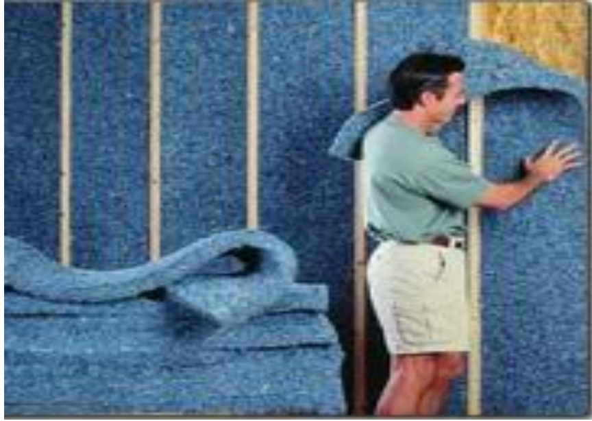
Resim 2.3. Pamuk tekstil atıklı ısı yalıtım malzemesi
