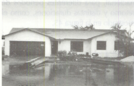
a) Alta Vulnerabilidad. El nivel del piso en la casa es similar al de la calle.
