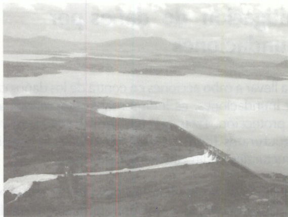
Fig. 37. Presa de almacenamiento.
