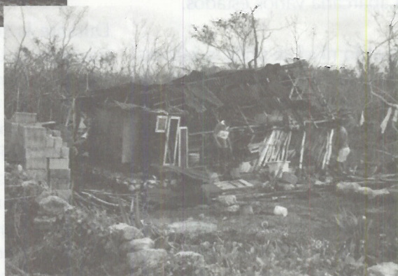
Fig. 48. Dos tipos de vivienda dañadas por el huracán Isidore.
