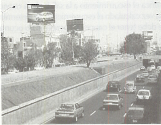
Fig. 41. Río entubado. Río de la Piedad, México. D.F.
