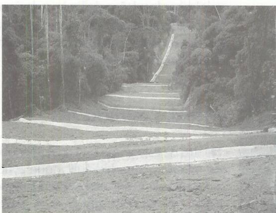
Fig. 39. Estabilización de pendientes.
