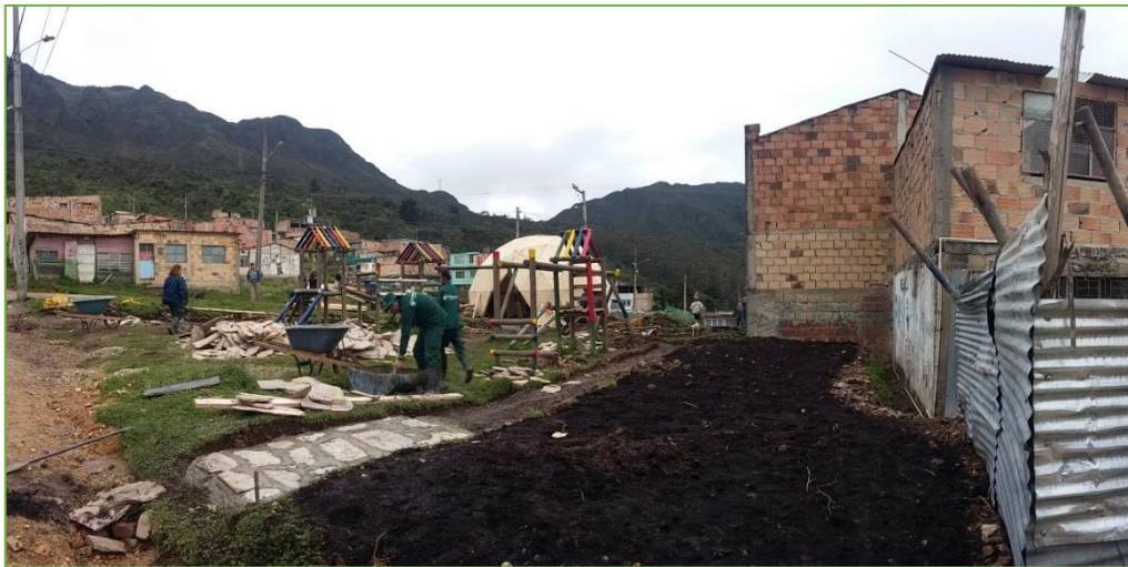
Fotografía 36: Ejecución del sendero en piedra- Parque Recrea
