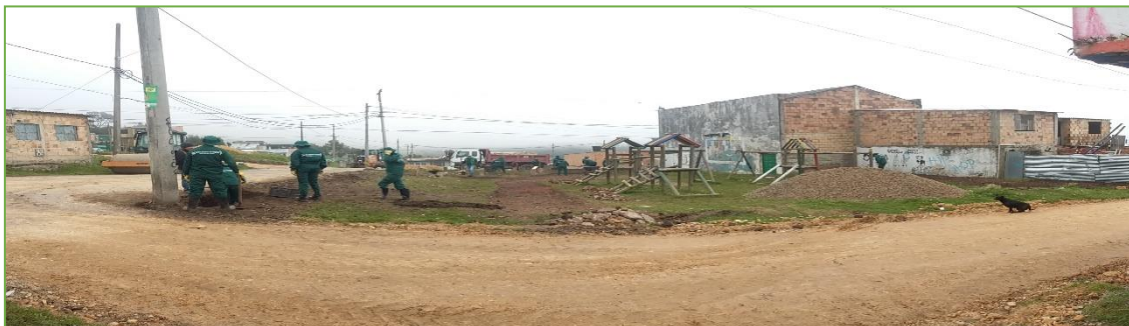
Fotografía 34. Parque Recrea, nivelación de terreno.
