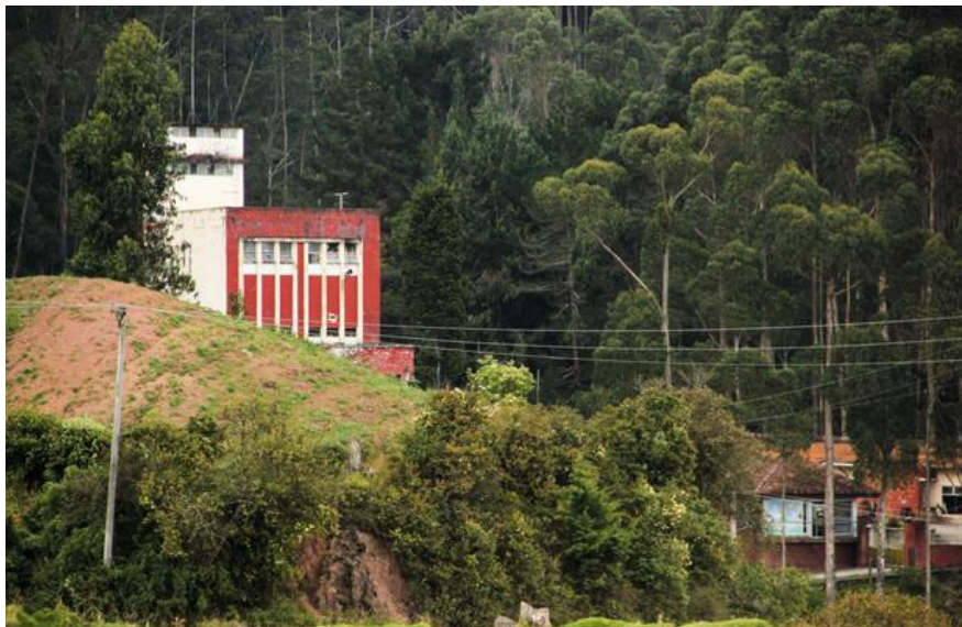
Fotografía 1. Instalaciones de la Antigua Cervecería La Alemana
