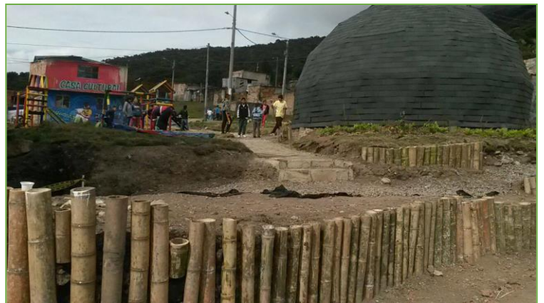
Fotografía 44. Trinchos en Guadua
