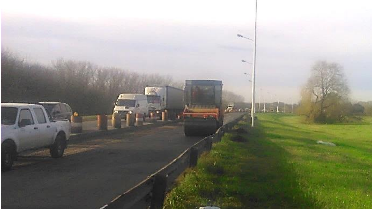
Figura 4. Tareas de compactación. Camino Parque del Buen Ayre
