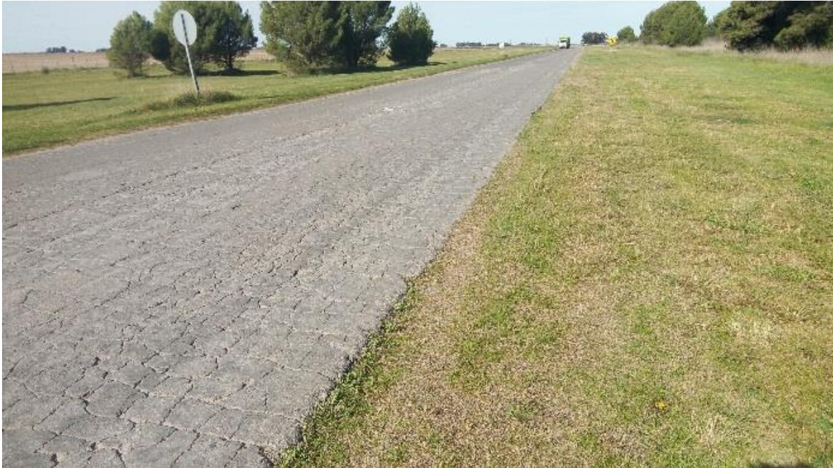
Figura 6. Ruta Provincial N° 75. Aspecto de la calzada antes de la obra
