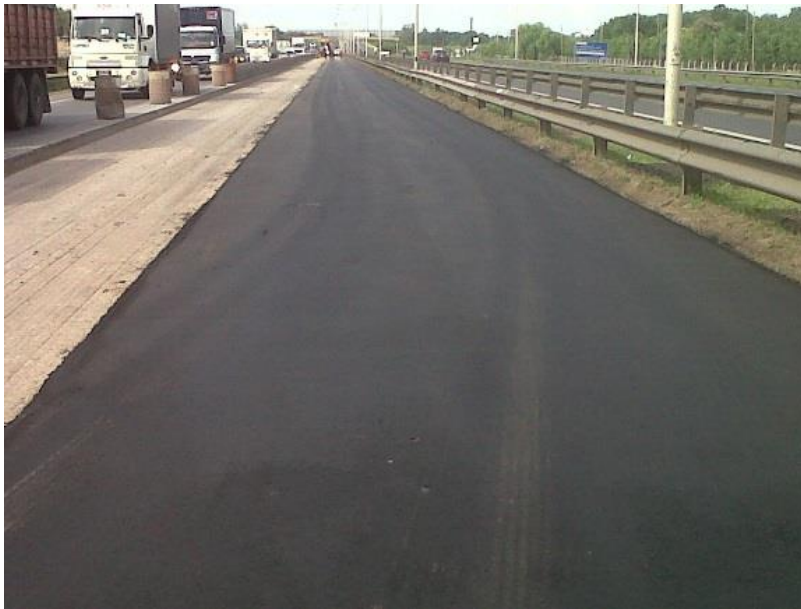
Figura 1. Capa de arena asfalto. Camino Parque del Buen Ayre
