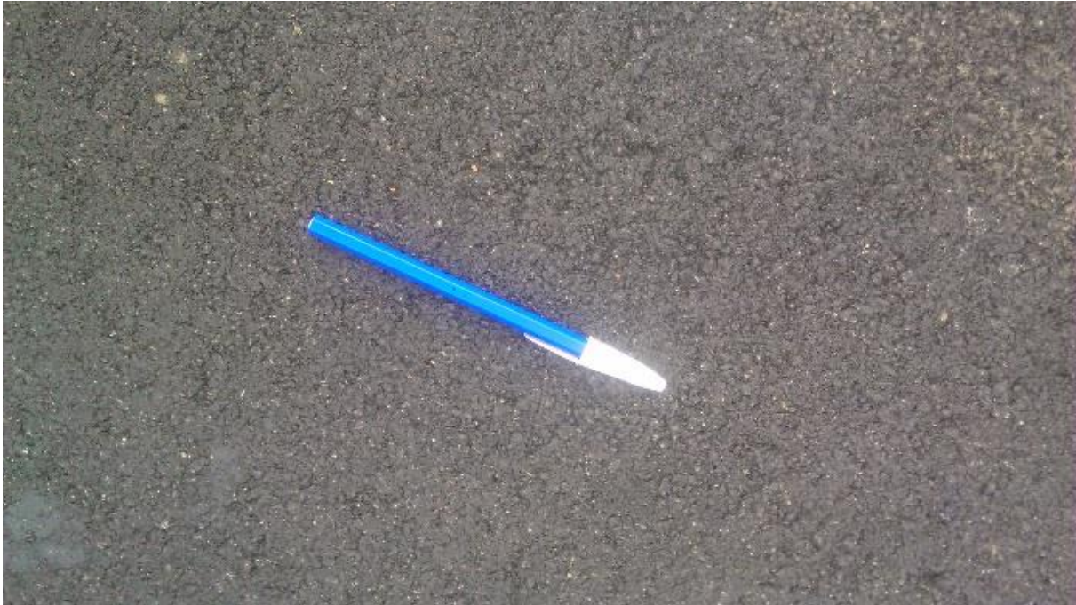
Figura 2. Aspecto superficial de la arena asfalto. Camino Parque del Buen Ayre.
