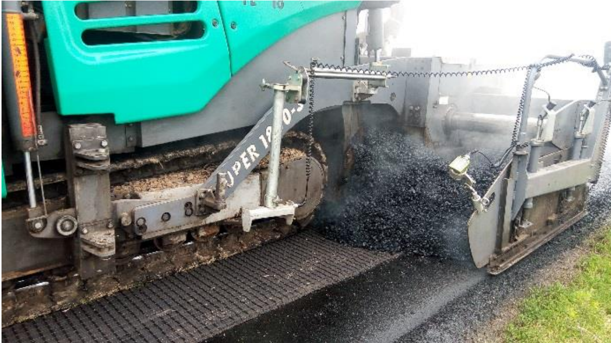
Figura 5. Tareas de colocación de mezcla asfáltica densa sobre arena asfalto con geogrilla. Ruta Provincial N° 6
