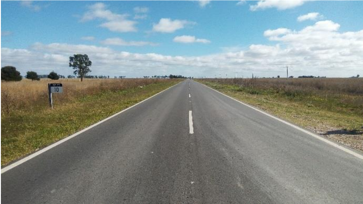
Figura 8. Ruta Provincial N° 75. Tramo finalizado
