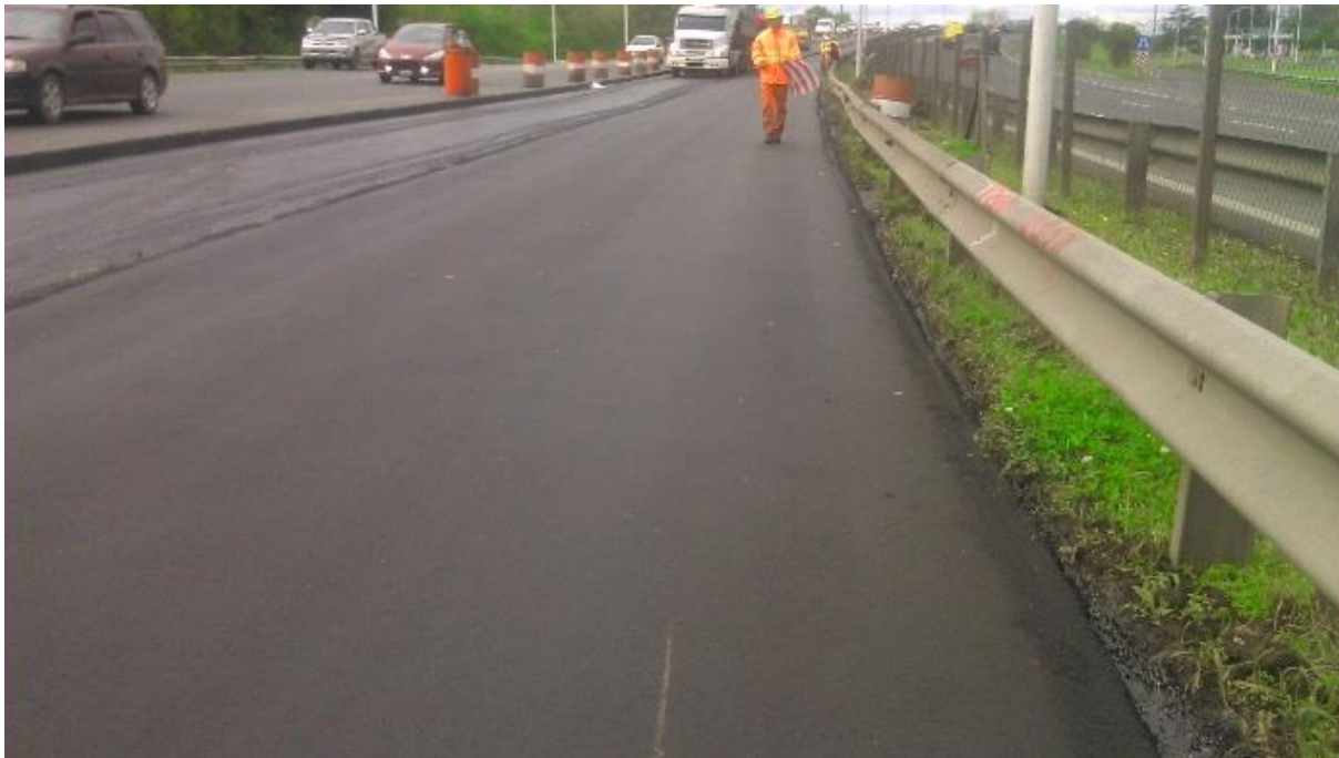
Figura 3. Capa de arena asfalto. Camino Parque del Buen Ayre
