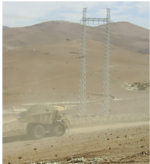
Estructuras de abatimiento de conductores, proyecto Compañía Minera Doña Inés de Collahuasi.
