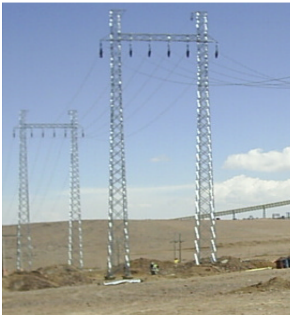
Estructuras de abatimiento de conductores, proyecto Compañía Minera Doña Inés de Collahuasi.
