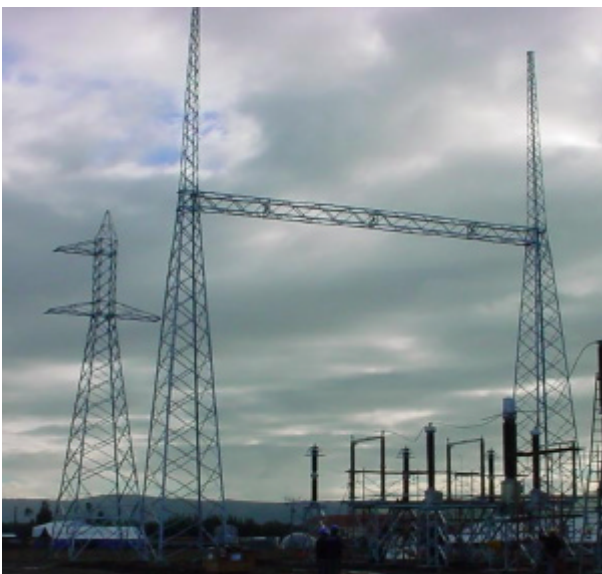
Estructura de remate línea 1x220 kV. Celulosa Arauco.
