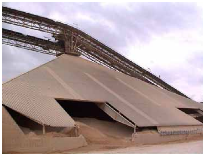
Stoccaggio sotto tettoia
