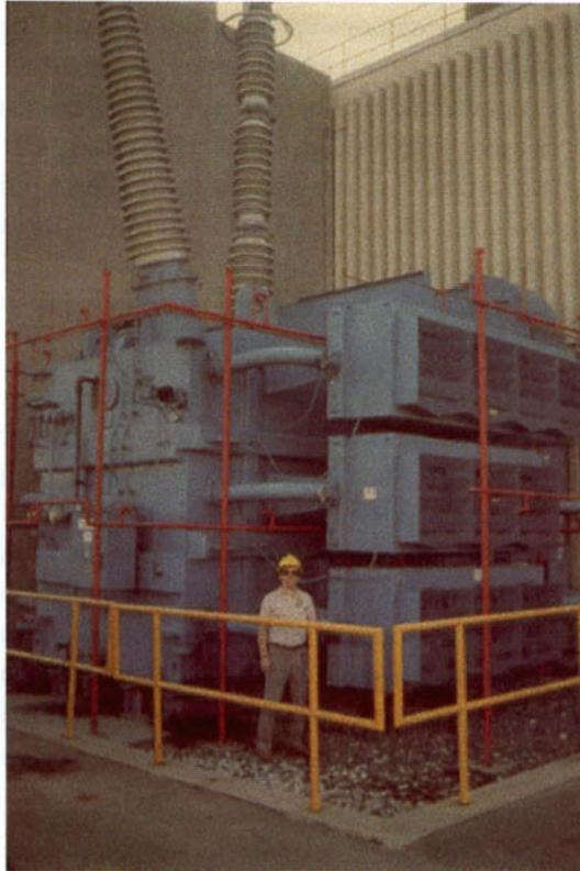
**Figure 3.4 - Ce transformateur de la centrale nucléaire de Delaware River, dans le New Jersey, a été endommagé par l'orage magnétique du 13 mars 1989. Il s'agit de l'un des trois grands transformateurs d'une unité totale de 1 200 MVA. Il coûte plus de 10 millions de dollars, et sa réparation peut prendre plus d'un an (crédit Compagnie électrique du Minnesota).**
