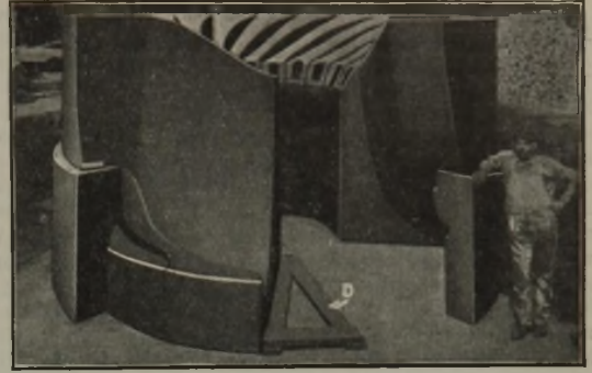
Abbildung 6. Die Läuferform nach dem Einlegen von neun Kernen.
