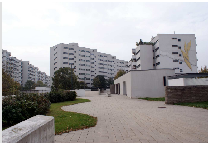
Zdjęcie 42. Neue Donau Wohnpark, widok ogólny (for. autor, 10.2009).
