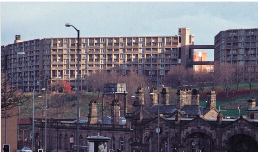
Zdjęcie 34. Park Hill, stan przed modernizacją [Colquhoun 2008, str. 14]
