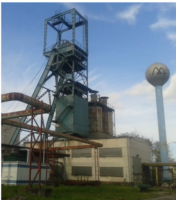
Obr. 8 Budova č. 12, šachetní budova Da 1, těžní věž. Foto autor.
