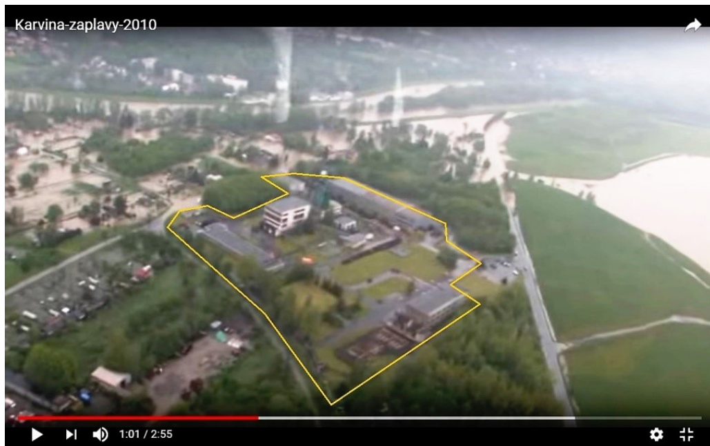
Obr. 21 Stav vody při povodni 2010 v okolí PZ, foto z vrtulníku PČR [24]
