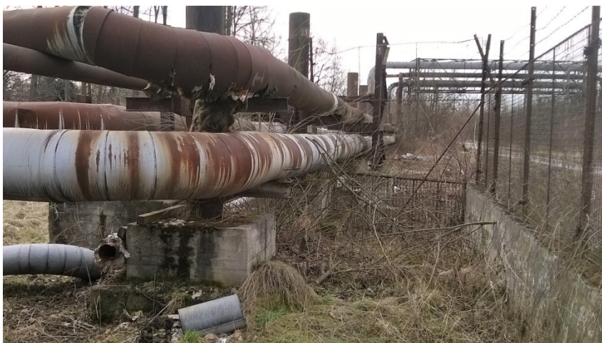
Obr. 12 Přívod horkovodu a vody přes plot. Foto autor.
