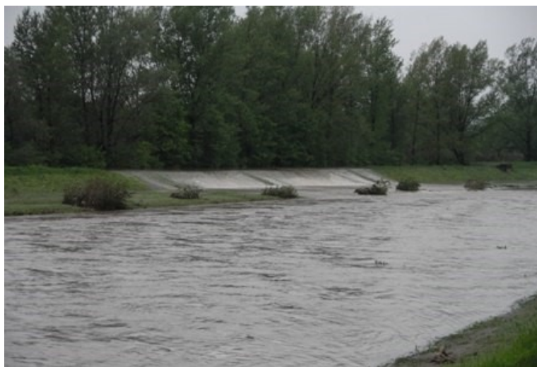
Obr. 26 Povodně 2010. Voda přetéká z prostoru kolem PZ do níže tekoucí Olše. [28]
