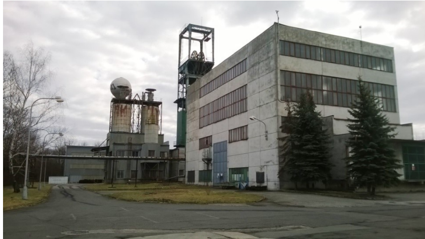
Obr. 9 Budova č. 15, strojovna těžního stroje Da 1. Foto autor.
