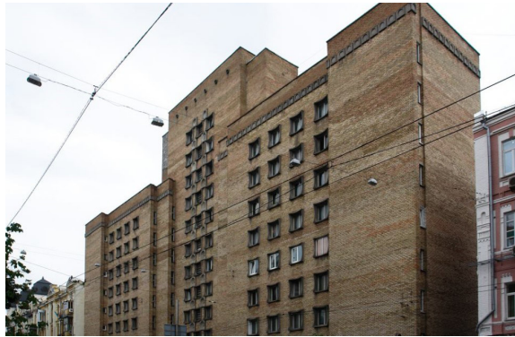
Рисунок 3 – Шумозахисний житловий будинок на вулиці Саксаганського, 45. Київ, 1979 рік. Архітектори: Н. Бруштинська, В. Шарапов, інженер Я. Шамес
