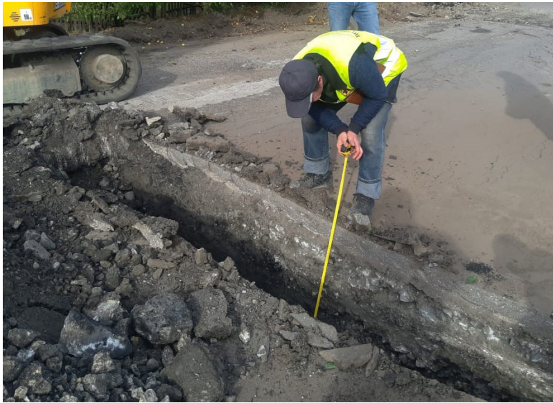
Рисунок 2 – Влаштування шурфу в існуючому дорожньому одязі з метою дослідження визначення складу матеріалів шарів
