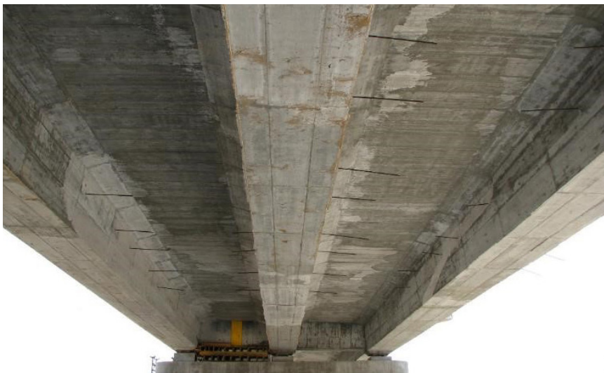
Рисунок 2 – Загальний вигляд досліджуваної прогонової будови естакади
