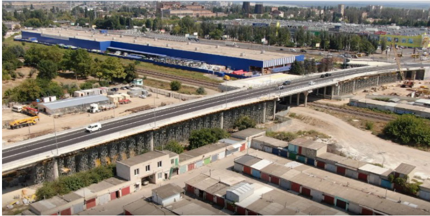
Рисунок 1 – Загальний вигляд споруди
