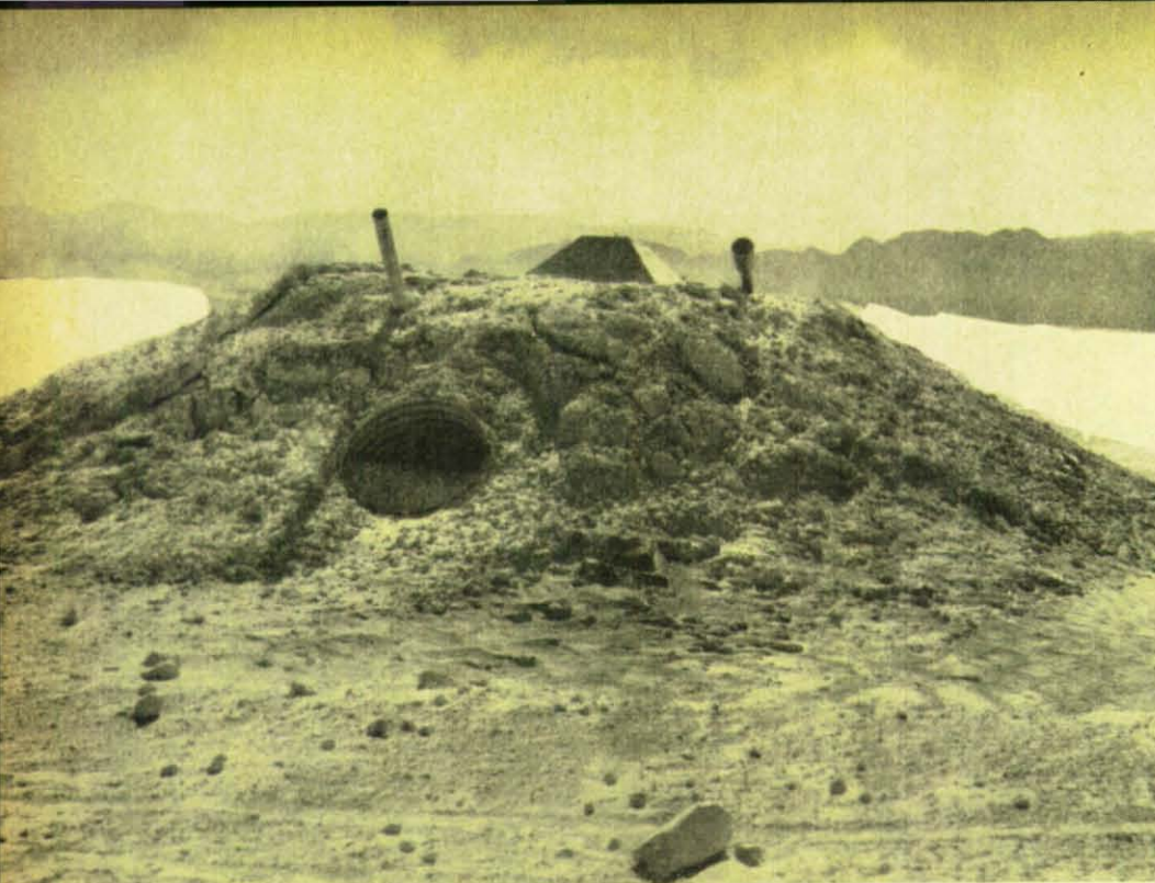
Aus Stahlbeton ist dieser Familien-Schutzraum gefertigt. Er hat sich bei den Atombombenversuchen in der Wüste von Nevada unter extremen Bedingungen gut bewährt.
