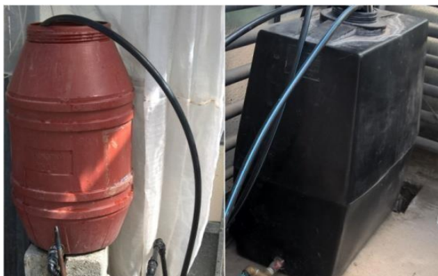
Εικόνα 15: Οι δύο δεξαμενές του αραιού θρεπτικού διαλύματος, χωρητικότητας 190L (αριστερά) και η κύρια δεξαμενή χωρητικότητας 500L (δεξιά).
