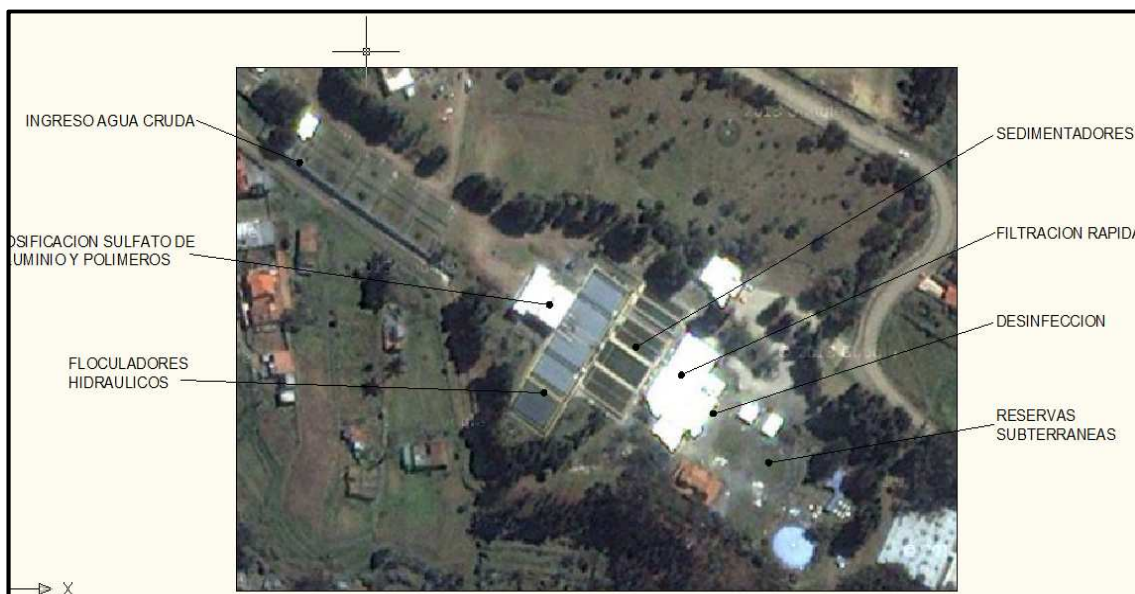
Figura 2.2 Planta de Potabilización de Agua de El Cebollar (Cuenca-Ecuador). Vista Aérea.
