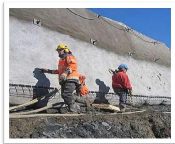
**Figure III.17** Schéma des tirants d'ancrages [1] **Figure III.18** Renforcement par ancrage [16]
