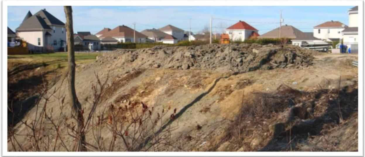
**Figure I.6 :** Exemple d'un remblai au sommet d'un talus pouvant être néfaste à sa stabilité [14].
