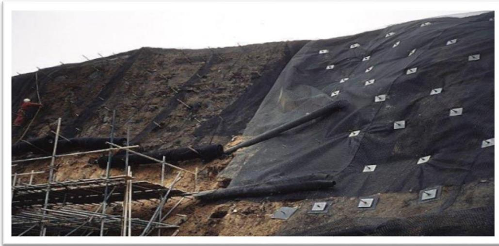
Figure III.15 : Un versant stabilisé par clouage [38].
