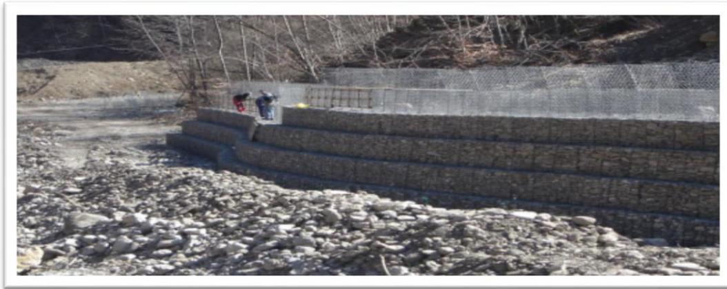
**Figure III.10** : Réalisation d'un mur en gabion [33].
