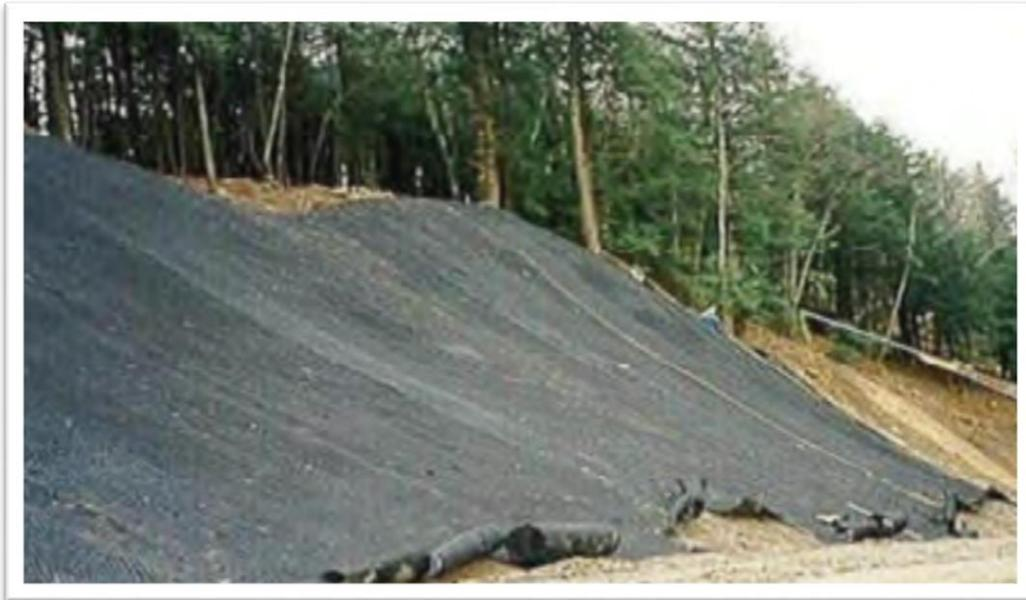
**Figure III.14:** Renforcement par géogridde [37].
