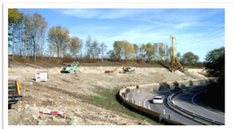
**Figure III.11** : Soutènements par pieux [38].
