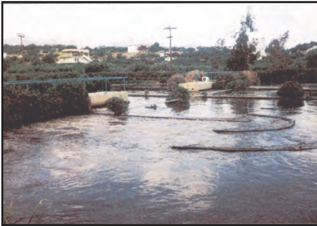
Ε ι κ ό ν α 2 . 3 1 Επεξεργασία υγρών αποβλήτων
