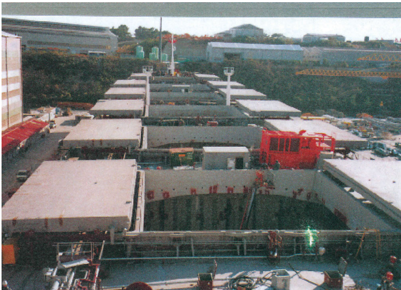
Φωτ. 9.7 Ανοίγματα καταστρώματος
