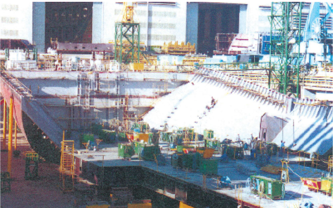
Φωτ. 9.2 Αρχικά στάδια κατασκευής - Διπύθμενα πλοίου
