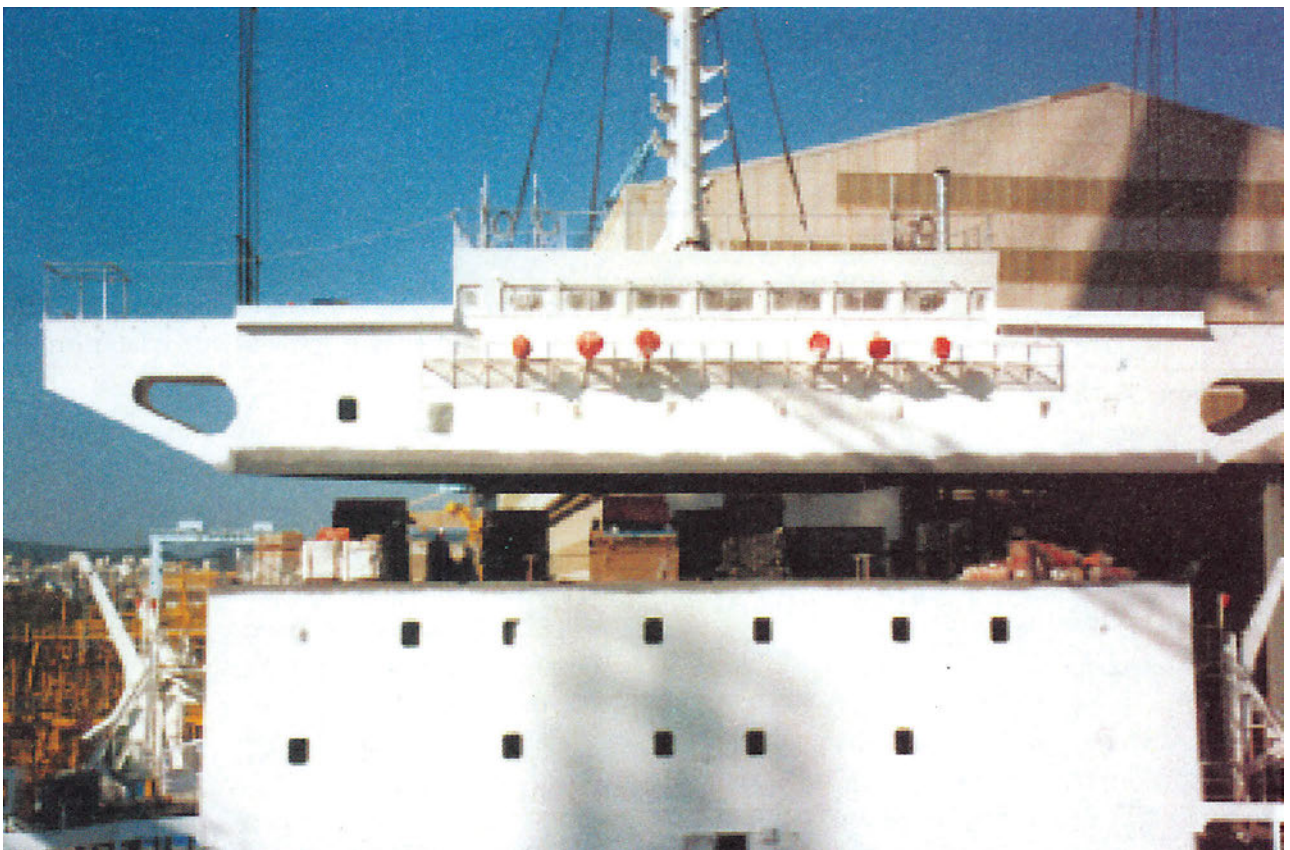
Φωτ. 9.6 Τοποθέτηση γέφυρας
