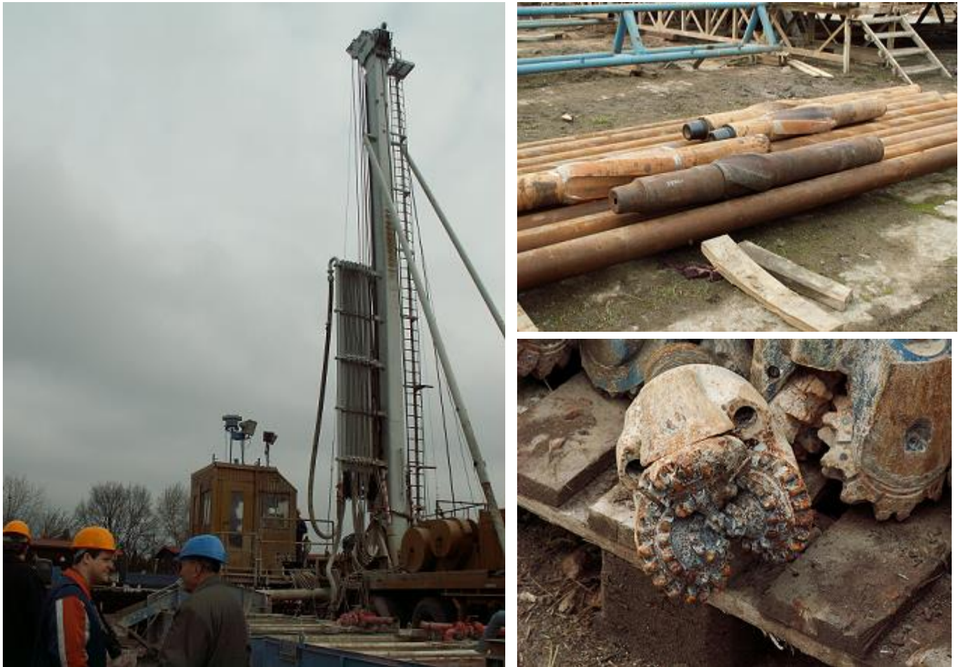
Obr. 2.13: Vrtná souprava, 2.14: Vrtné tyče a jádrovnice, 2.15: Vrtné hlavice (vrt Litoměřice). [17]
