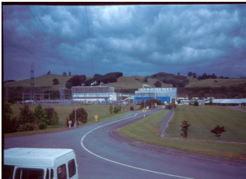
Obr. 8.5: Geotermální elektrárna Wairakei, Nový Zéland, severní ostrov.[17]
