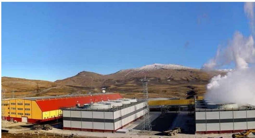
Obr. 8.8: Geotermální parní elektrárna Mutnovská 2, na Kamčatce. (Archiv CVEL, 2008)
