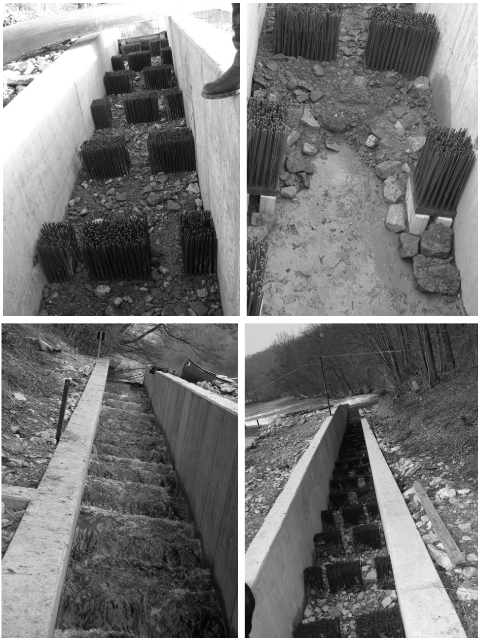
Obr. 20 Kartáčový RP, Doebritschen, Thuringia, řeka Saale (Hydrolaboratoř Schleusingen, W. Schmalz)
