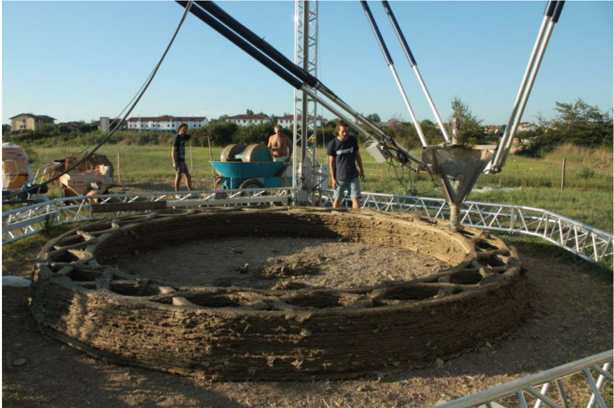
Figura 20. BigDeltaWASP 12m (fuente: http://www.wasproject.it )
