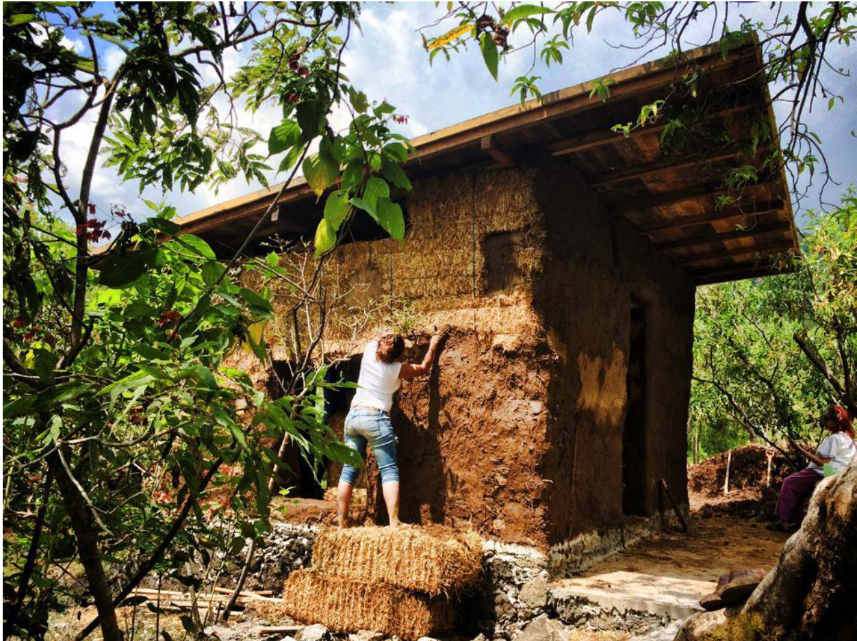
Figura 16. Casa con fardos de paja y tierra (fuente: http://enlacearquitectura.com/ ).
