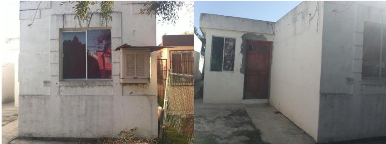
Figura 22. Vivienda situada en avenida Bugambilias (fuente: autorreferenciada).
