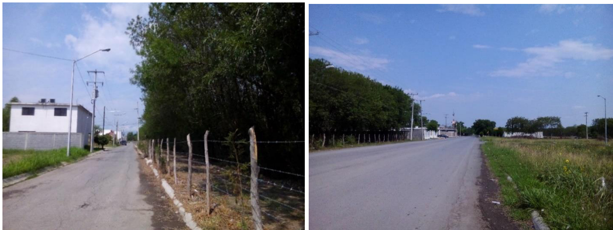
Figura 35. Vista del terreno fachada Calle el Pirul, dirección suroeste (izquierda). Fachada con vista a la calle Camino al Vapor, dirección noroeste (derecha), tomada el viernes 08 de septiembre de 2016 (fuente autorreferenciada).
