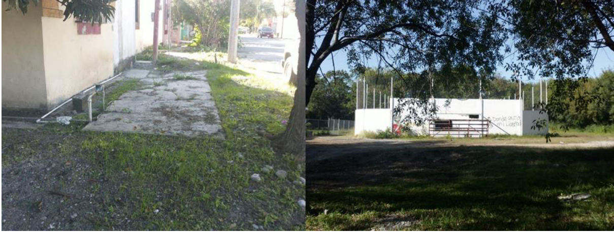
Figura 27. Vialidades de calle prolongación Orquídea, Fraccionamiento Los Sabinos (fuente: autorreferenciada).
