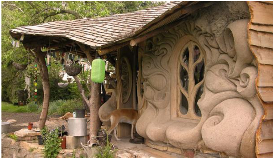
Figura 13. Vivienda construida con COB (Fuente: http://www.naturalhomes.org/es/homes/goatlings.htm , 2012).
