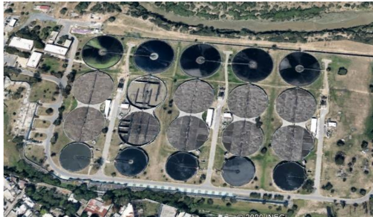
Figura 31. Fotografía satelital de la Planta Norte
