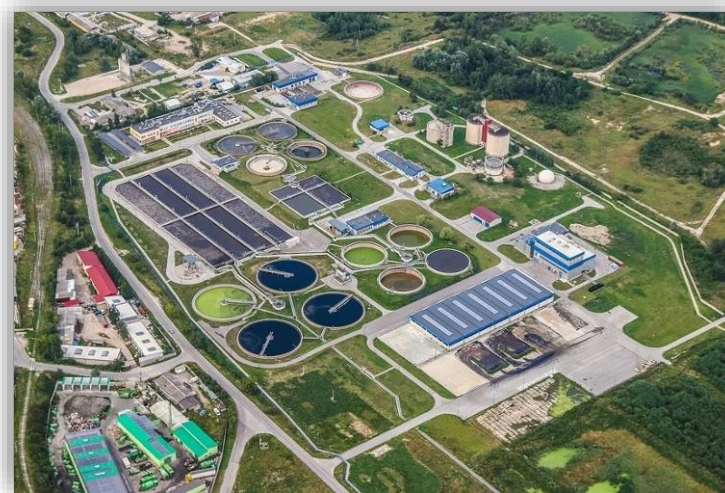
Figura 1: Planta de tratamiento de agua residual (PTAR).
