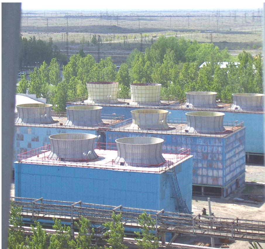
*Рис. 8.10.* Градирни нефтеперерабатывающего завода – источник попадания углеводородов в атмосферу
