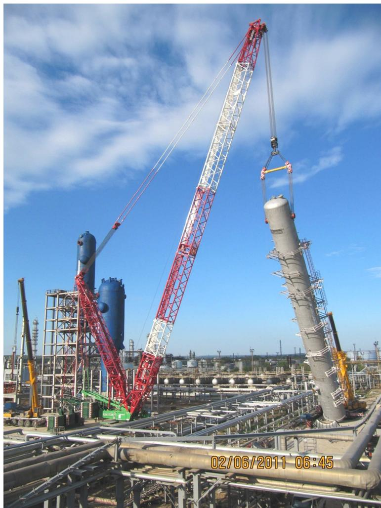
*Рис. 8.6.* Монтаж ректификационной колонны для разделения продуктов крекинга FCC на КНПЗ
