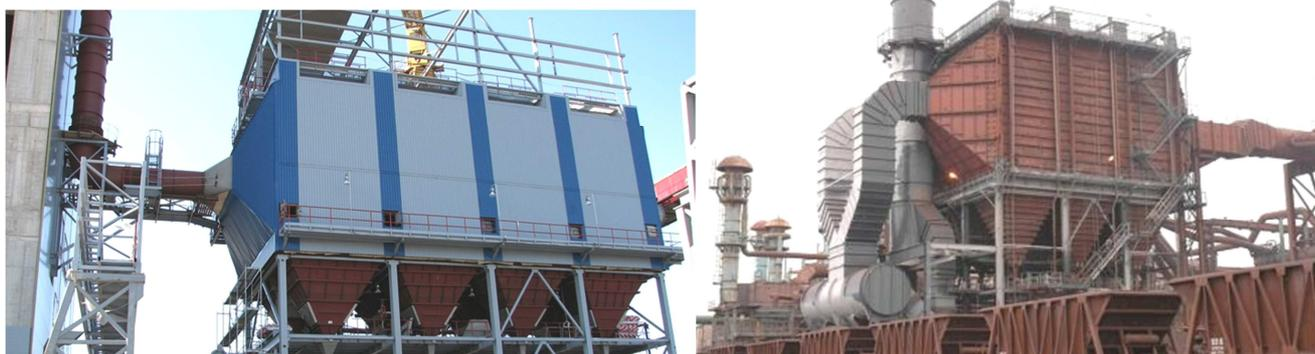
Рис. 5.12. Внешний вид промышленных электрофильтров
