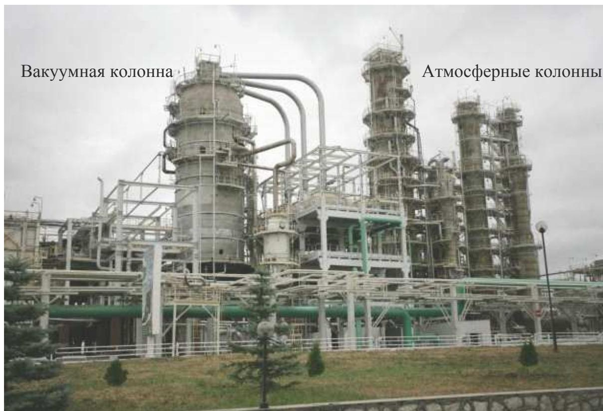
Рис. 8.1. Установка ЭЛОУ-АВТ-6
