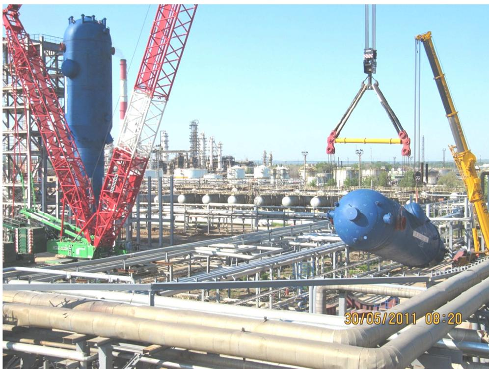
Рис. 8.5. Монтаж реакторов каталитического крекинга FCC на КНПЗ
