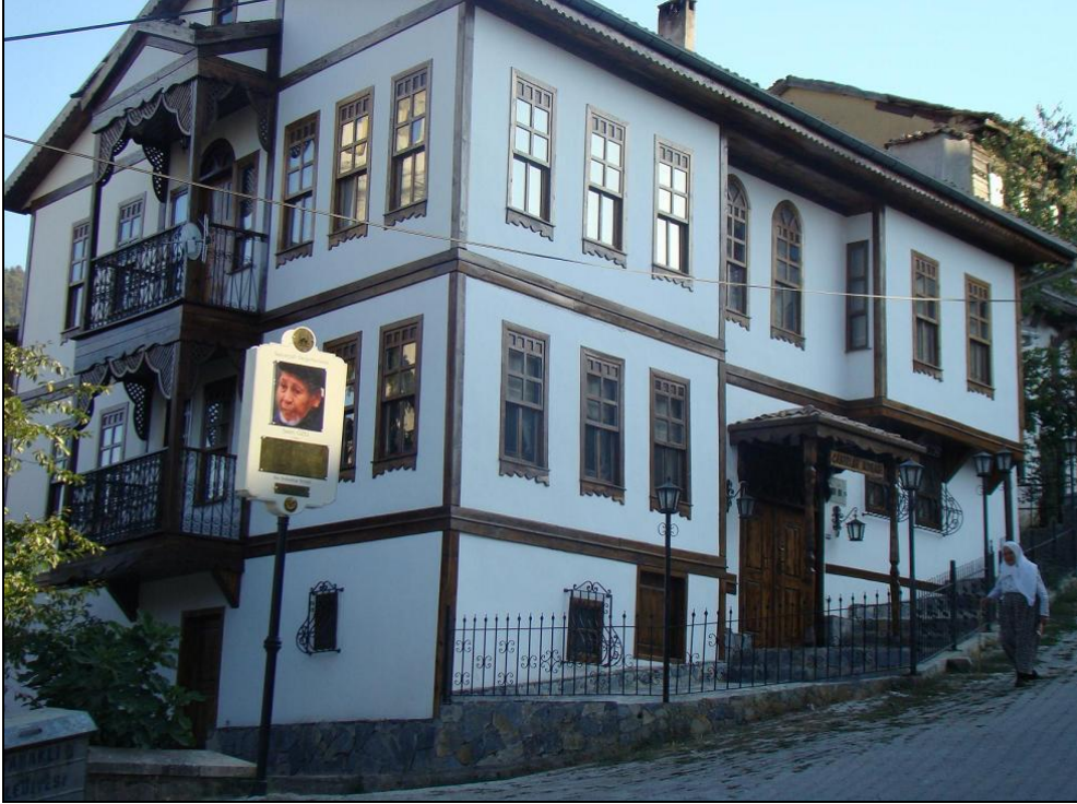
Taraklı'da restore edilmiş 3 katlı bir ev
