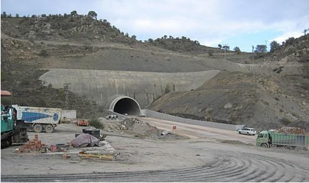
Boyabat'ı Sinop'a bağlayan Dranz Tuneli yapım aşamasında iken
