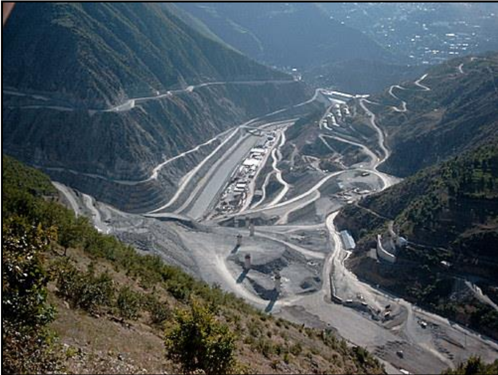
Artvin Barajı inŐaatı
