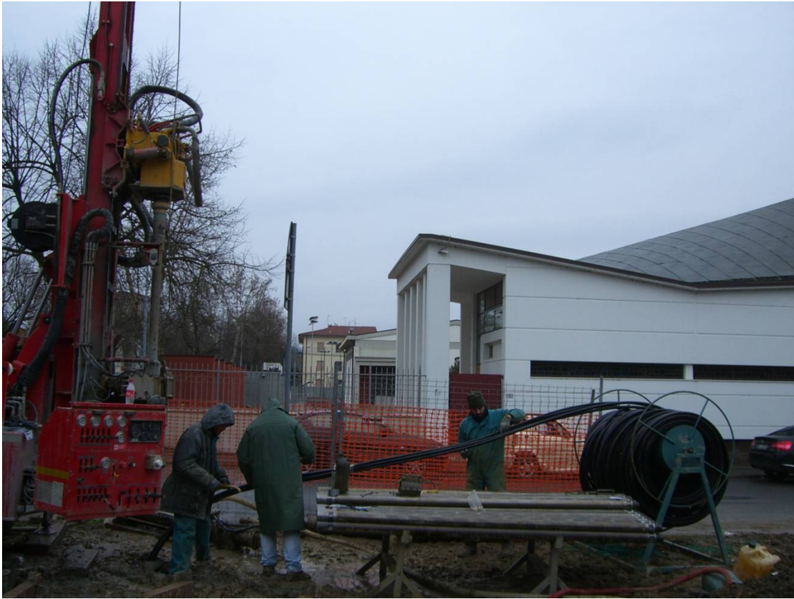
Montevarchi centro urbano (cantiere asilo comunale) - perforazione a circolazione di fanghi e rivestimento del foro-
