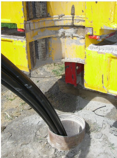
tubazione di rivestimento messa in opera
