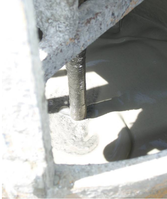
Dettaglio del premiscelato da iniettare
