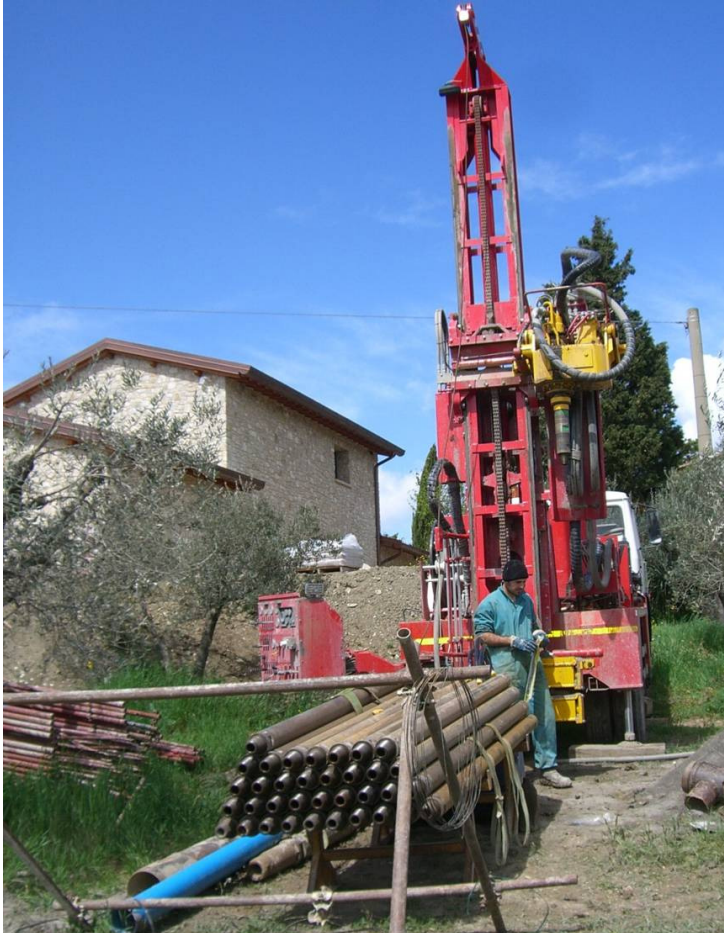
Gualdo Cattaneo (PG)- perforazione a rotopercolazione senza rivestimento del foro-
