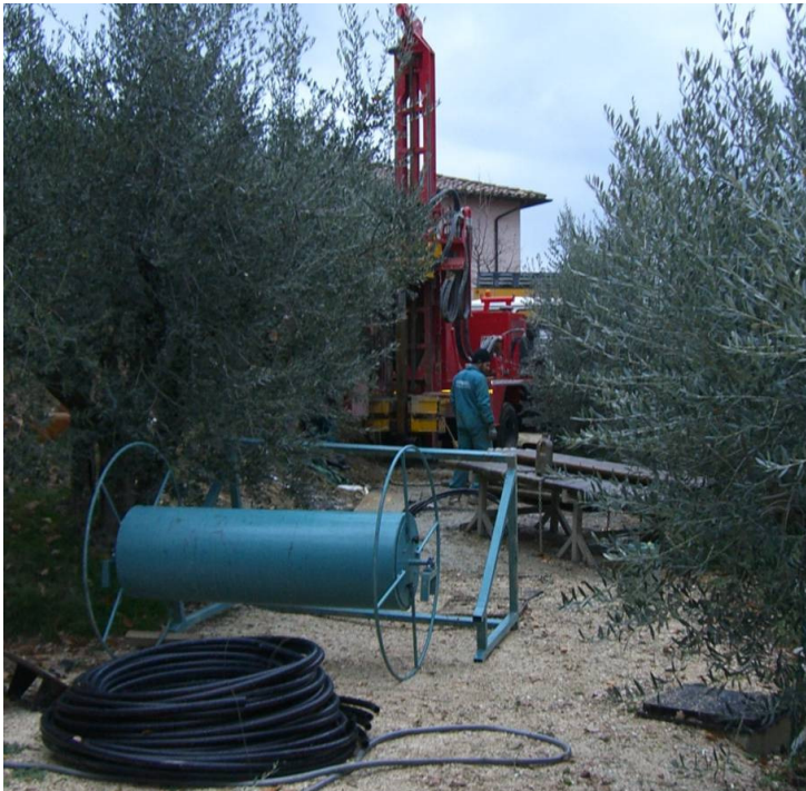
Bettona (PG) - cantiere a rotopercolazione con rivestimento del foro-
