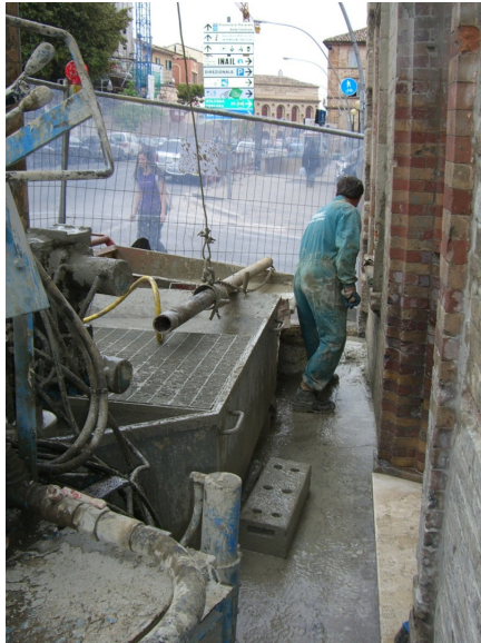
Perforazione con vasca stagna
