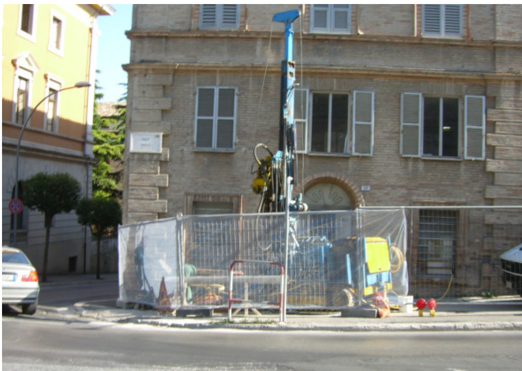
(Macerata centro) -Perforazione a circolazione di fanghi con vasca stagna e rivestimento del foro-
