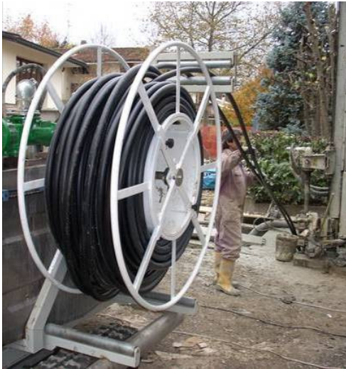
Inserimento sonde sul foro
