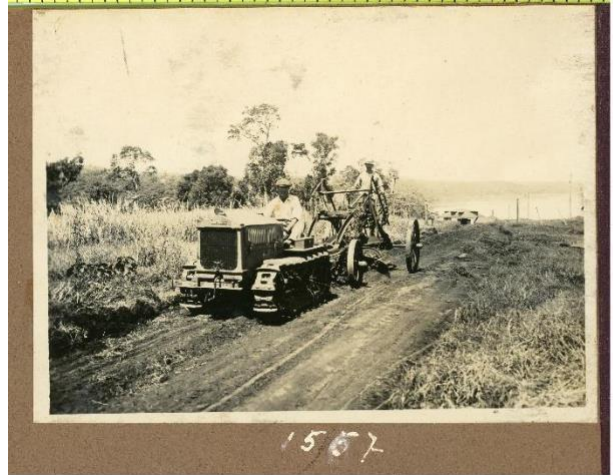
Imagen 7: Fotografía en donde se puede observar el número en corrector y manchas de humedad.
