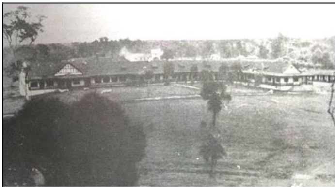
Figura: Edifício da Comisaria em construção (1941) – Coleção Romaro
