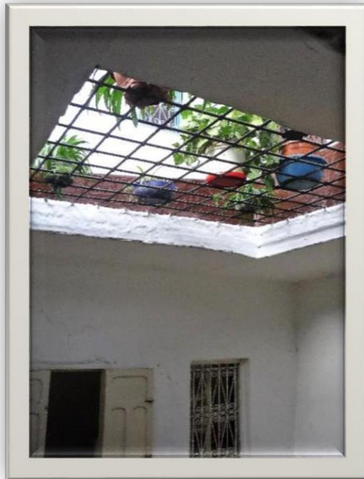
4- Claraboya en casa-patio del mellah, 2019
