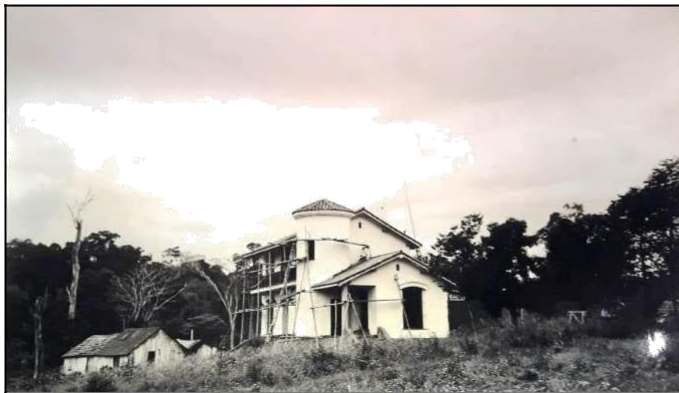
Figura 12: Edifício da Comisaria em construção (1941) – Coleção Romaro Fonte: Arquivo da DPHC
