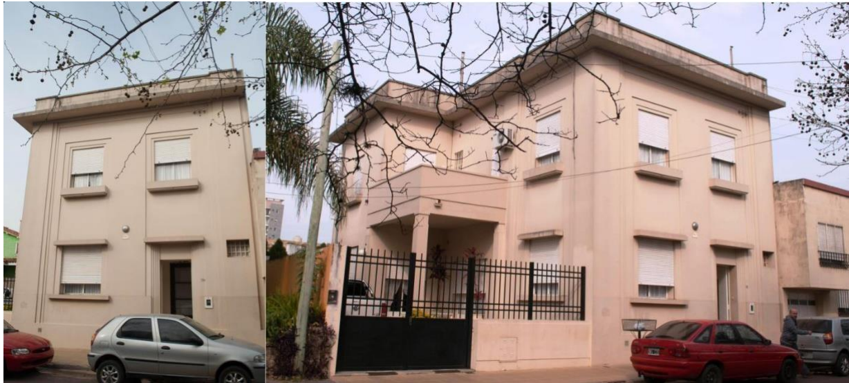
(Figura 19 y 20) - Vivienda MASVERNAT
